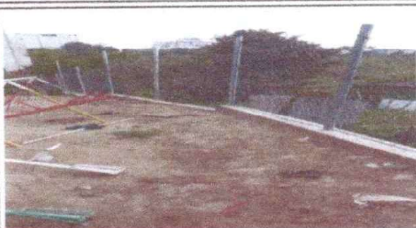
Foto 1: Colocacion, tubo, malla.
